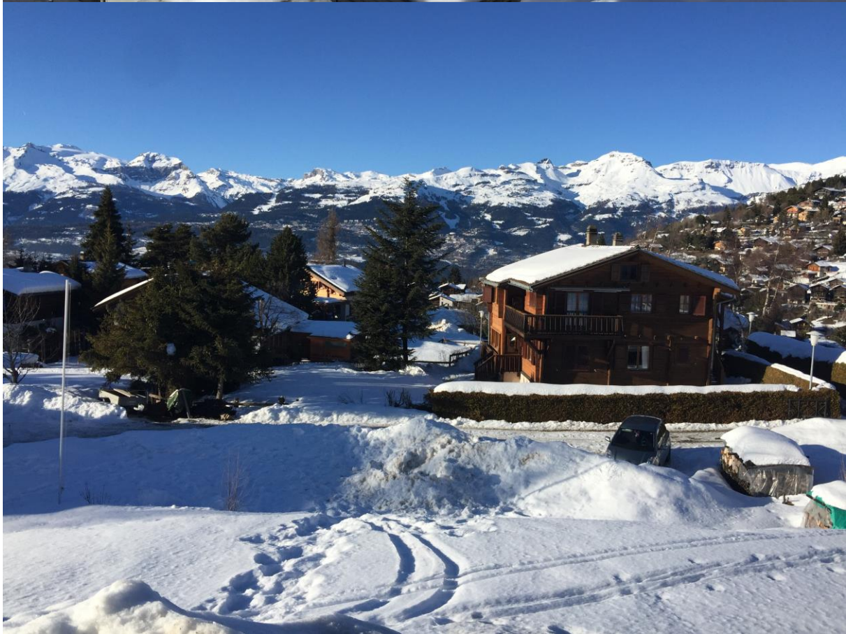
EN CONSTRUCTION Photo courant janvier 2018
