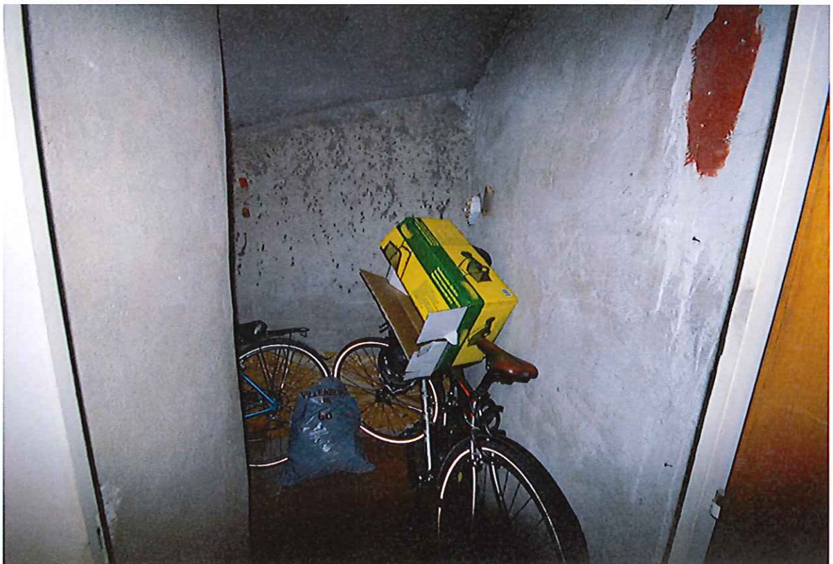
Réduit sous cage d'escalier
