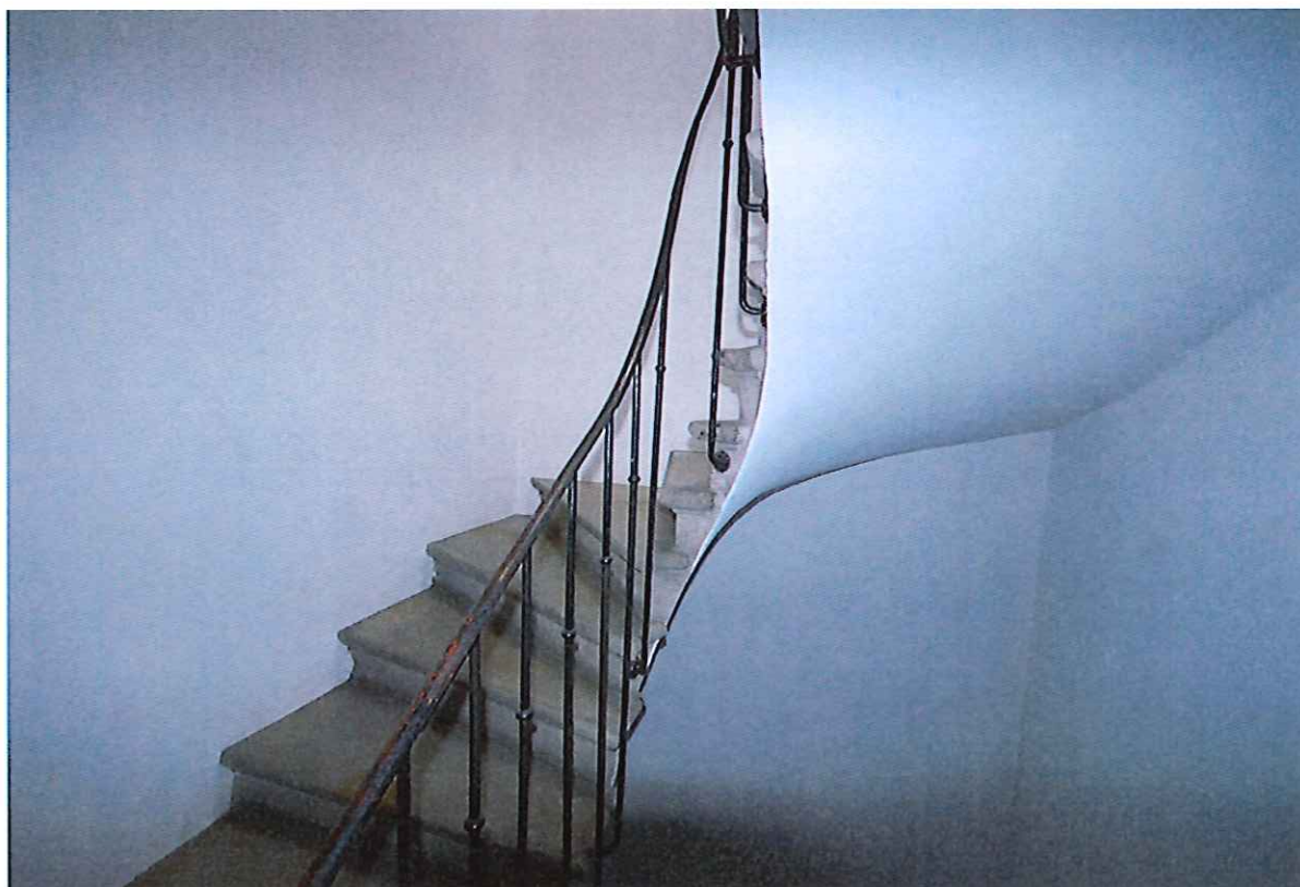
Escalier pour monter aux combles
