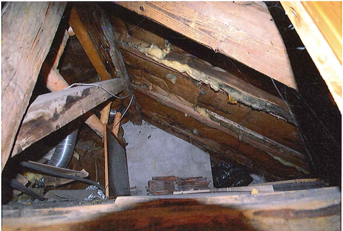
Petit galetas pour accéder sous la toiture depuis une trappe de la 2 ème chambre
