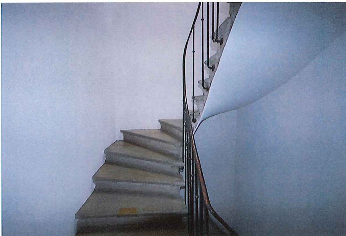
Escalier pour monter à l'étage
