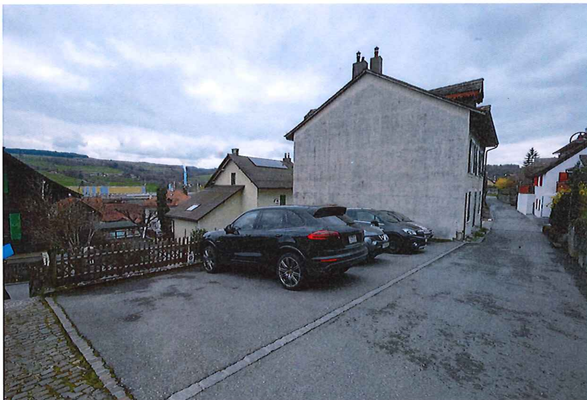
Façade Nord-Est avec places de parc
