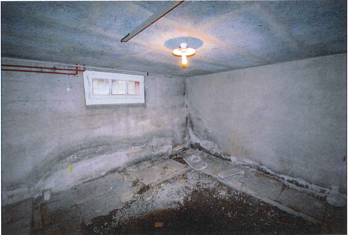
Cave au sous-sol
