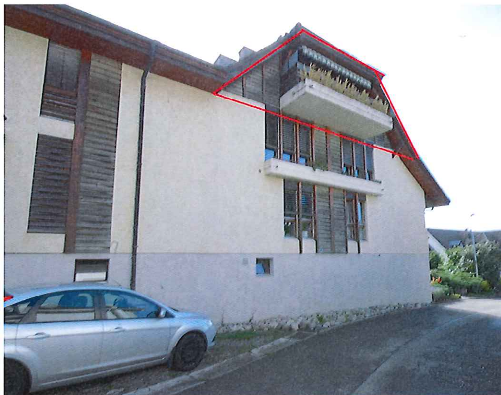
Façade Sud-Ouest avec le balcon de l'appartement
