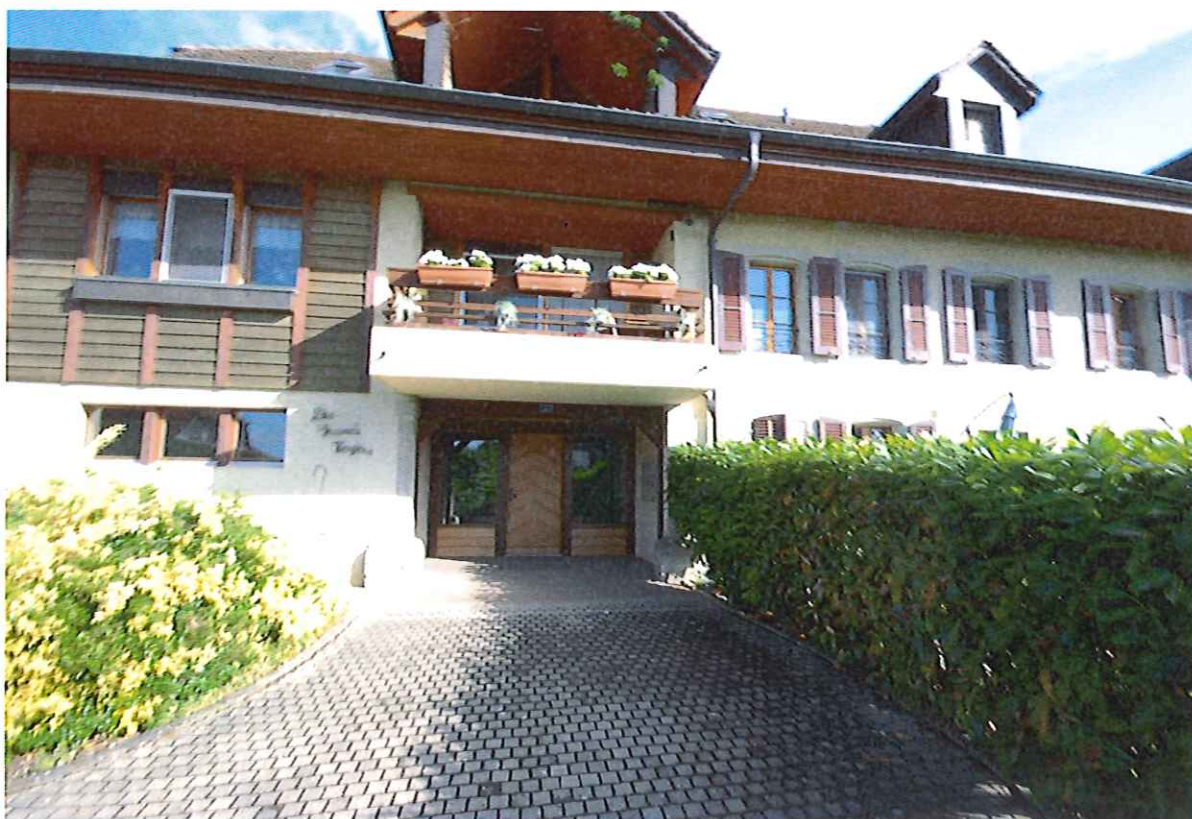
Entrée de l'immeuble
