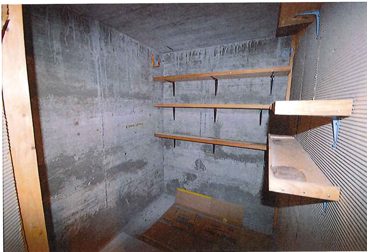
Cave au rez-de-chaussée
