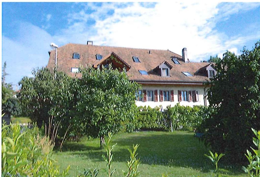
Façade Sud-Est de l'immeuble
