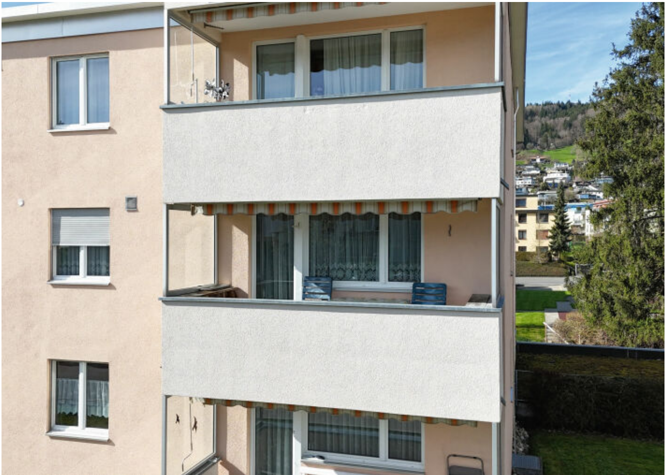
Ansicht Balkon aussen
