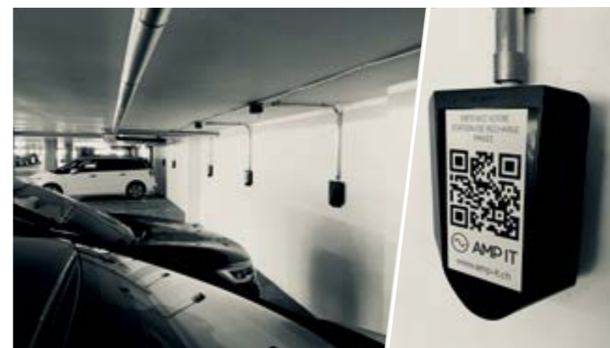
La borne n'est pas chère (environ 1800 francs pièce), c'est l'équipement qui l'accompagne qui fait gonfler la facture. LDD
