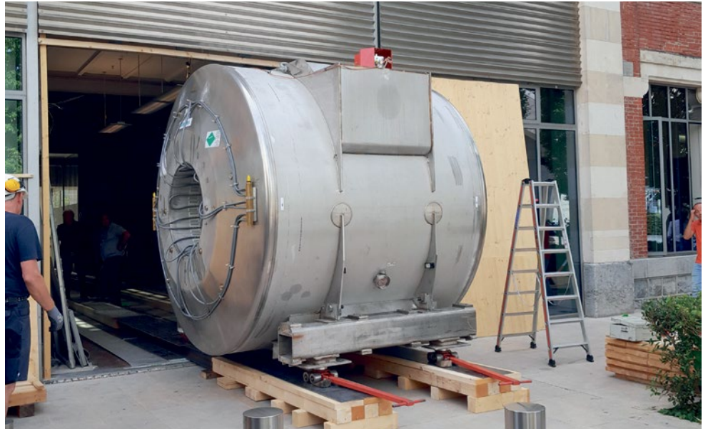
Manœuvres ultra-précises: l'IRM de 20 tonnes doit d'abord glisser sur les rails.
