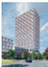
8. Tour Tilia (27 étages) Prilly. Sera composée d'un mix béton-bois. Pose de la première pierre fin avril 2024.
