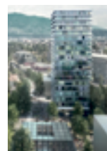
5. Tour Opale (19 étages) Chêne-Bourg. Défi d'une réalisation durant la pandémie. Terminée en mai 2020.
