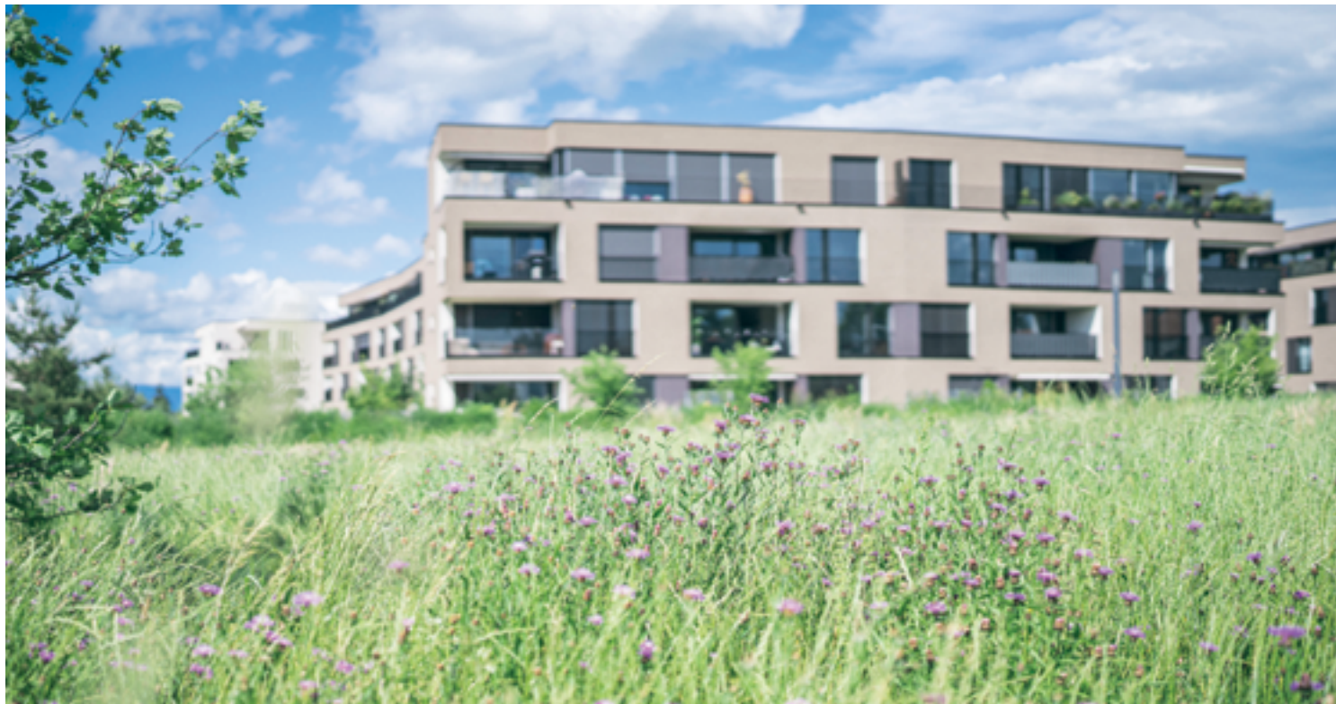
Le quartier des Portes du Lac (Estavayer-le-Lac) accueillera à terme plus de 1500 habitants. DR
