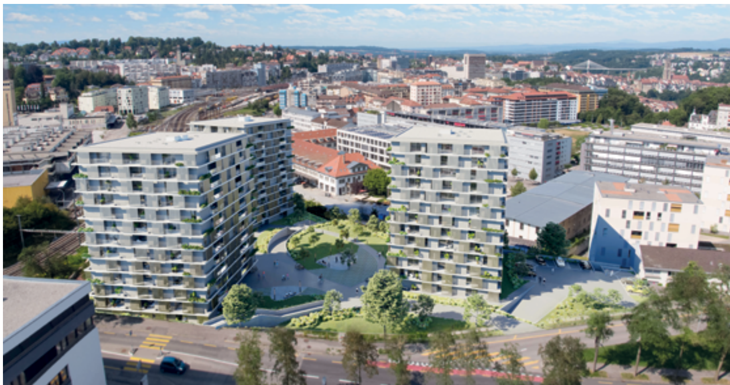
Fraîchement sorti de terre, le Parc de la Fonderie a offert 226 nouveaux logements aux Fribourgeois. DR
